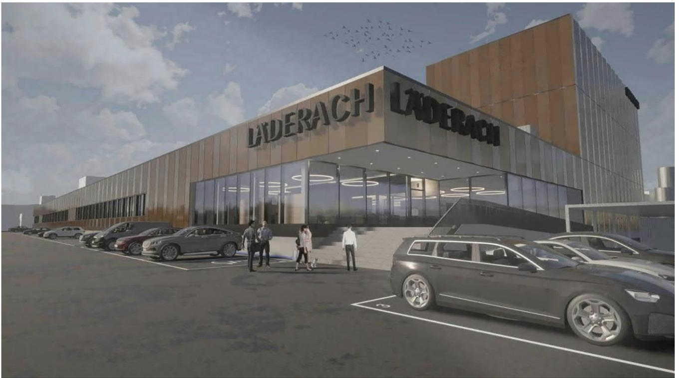
Schokoladenfarben: Die neue Fabrik bekommt eine Fassade aus eingefärbtem Aluminium, wie die Visualisierung aus dem Baugesuch zeigt.
