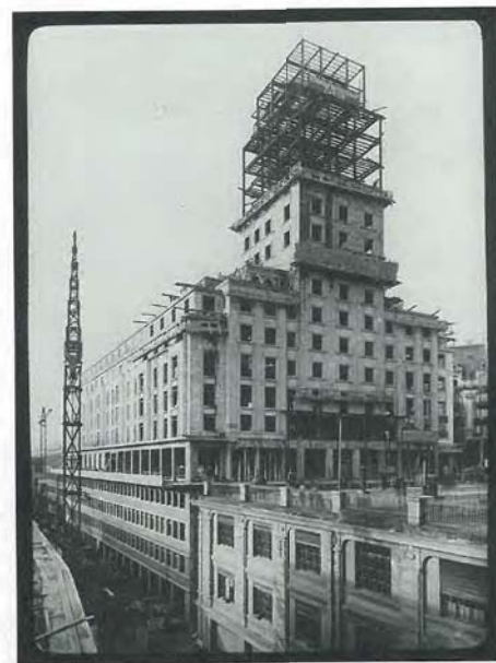
Die Cité Bel-Air in Lausanne (1932) ist eine der seltenen Geschossbauten mit Eisenkonstruktion.
