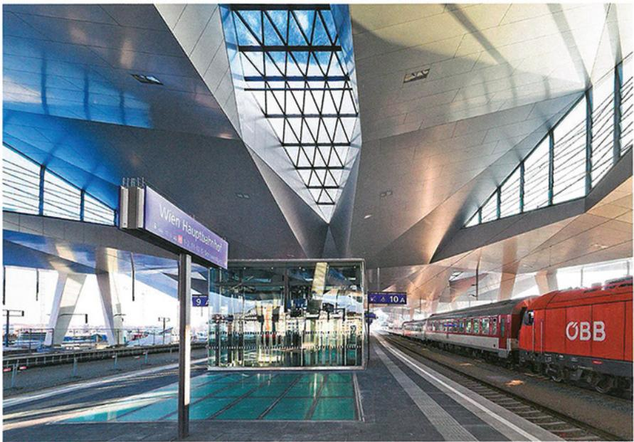
2 Zastřešení nástupišť ve formě prolamované konstrukce se světlíky umožňuje průchod slunečních paprsků a představuje architektonicky nejvýraznější část stavby.
